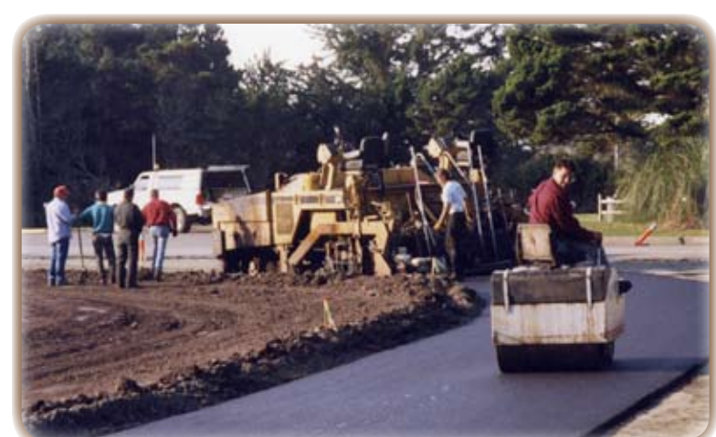
Rolling the asphalt.
