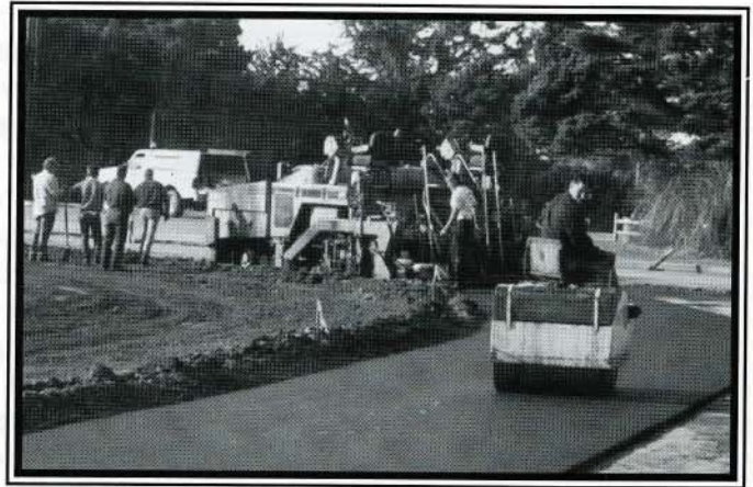
Rolling the asphalt.
